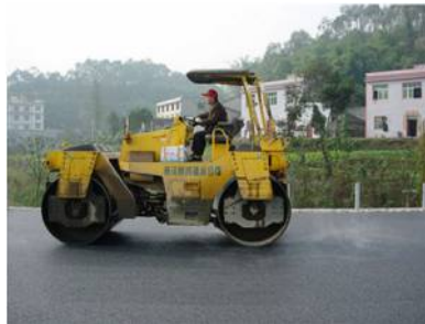
重庆的高速公路建设施工工地上使用SW750N的照片局部
