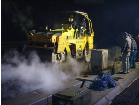
图8：在桥梁铺设施工中水平振荡压路机效果非常好
