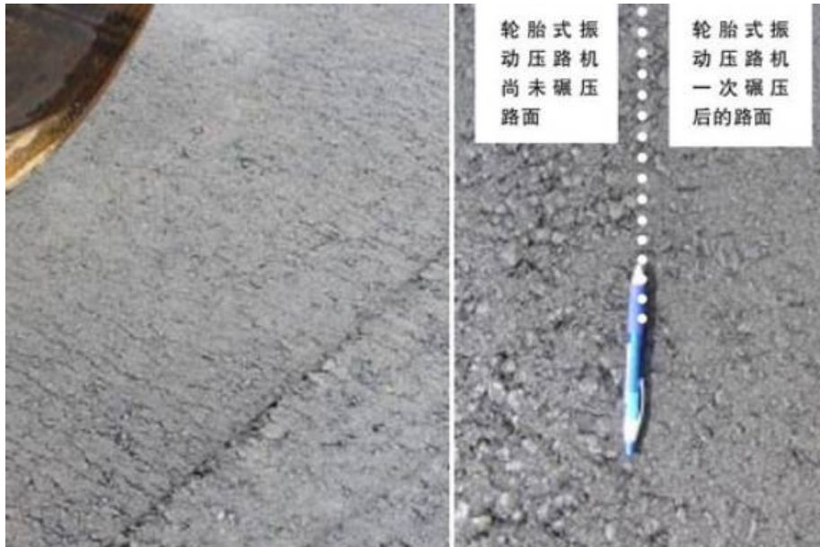
图9：以往的振动压路机产生细微的龟裂 图10：轮胎式振动压路机消灭了龟裂状态
