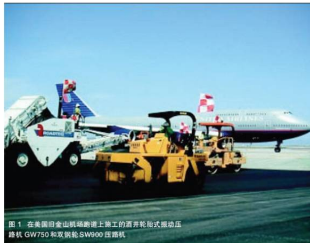
图1: 在美国旧金山机场跑道上施工的酒井轮胎式振动压路机 GW750 和双钢轮 SW900 压路机
