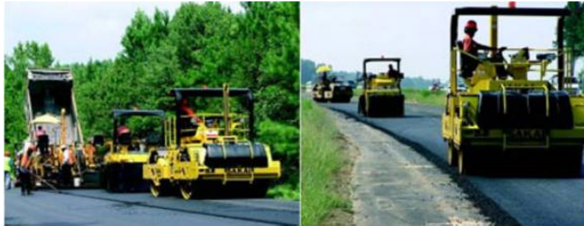
图3：以往的碾压机械要3台编组 图4：新型振动碾压机械用2台编组
