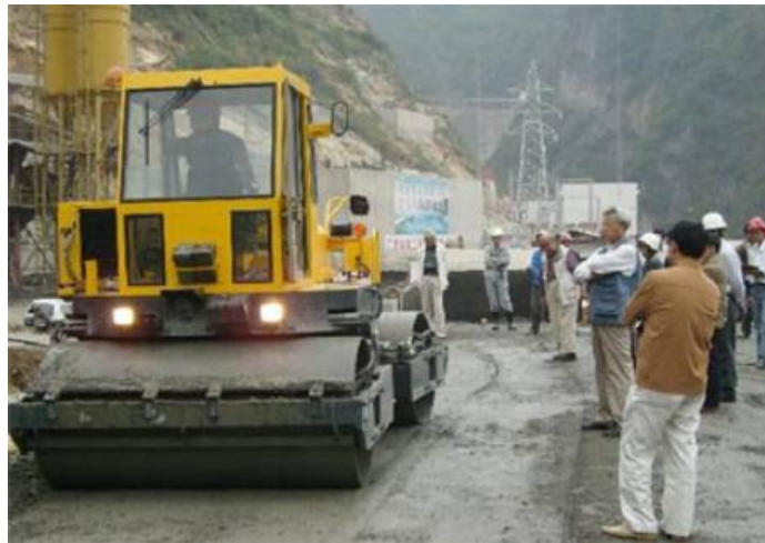
图 3: 在中国贵州省的大坝现场首次进行 SD451 的性能试验
